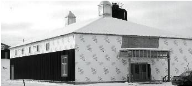
사진 4: 창문과 문의 개구부 주위에 비닐링과 함께 사용하여 건물이 건조한 상태를 유지하도록 도와주는 내후막
