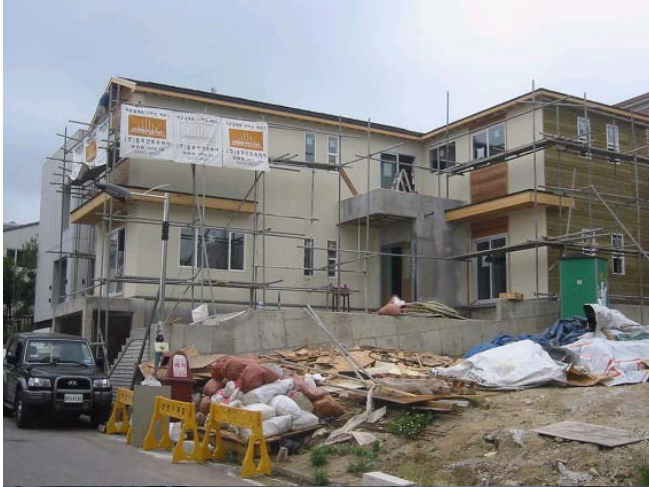
아쿠아락 외벽 시공
