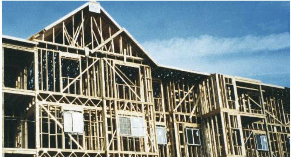
사진 6: 안전한 주택에 대한 건축 규정을 충족시키는 목조 시공
